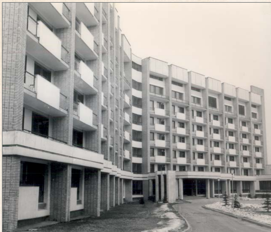
▲ Госпиталь в Сокольниках. Окончание основного этапа строительства.
