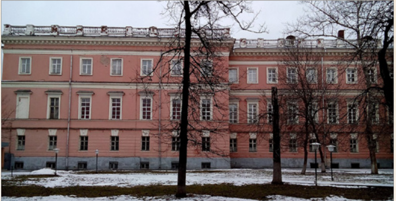
▲ Здание Алексеевского военного училища
