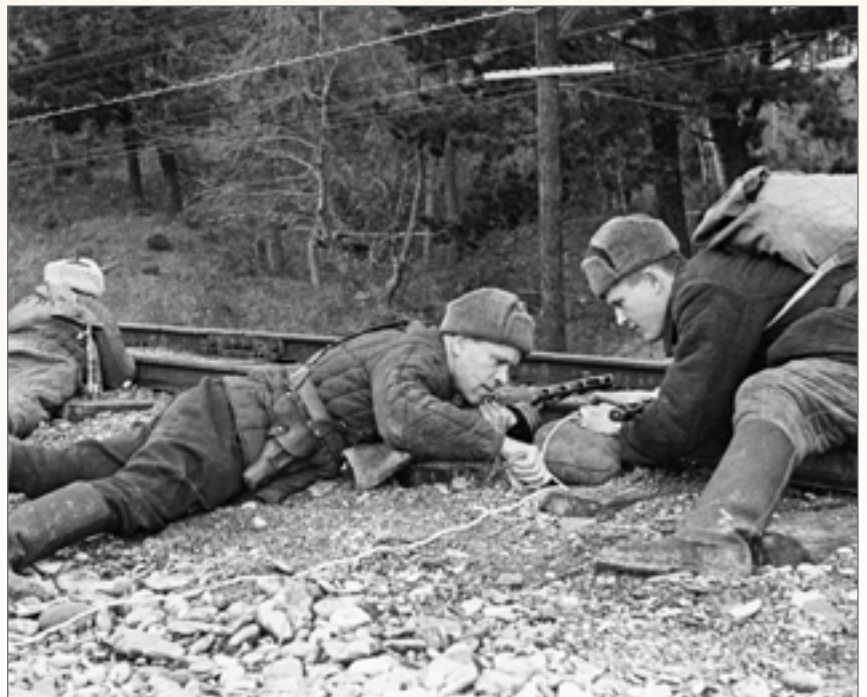
▲ Установка противопоездной мины
